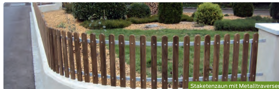
Staketenzaun mit Metalltraversen
