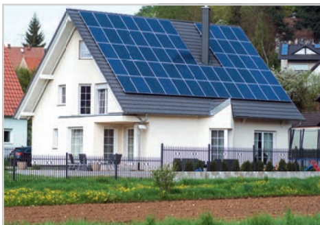
Einfamilienhäuser mit PV-Volleinspeiseanlagen
