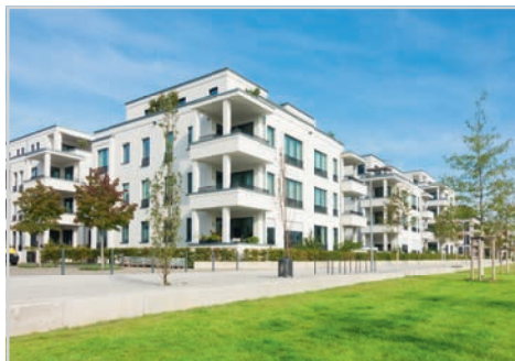
Ein- und Mehrfamilienhäuser mit ungünstiger PV-Dachsituation
